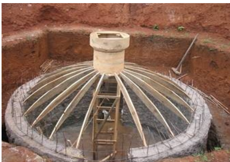
Biogassreaktor murt i naturstein. Forskalling av domen pågår
