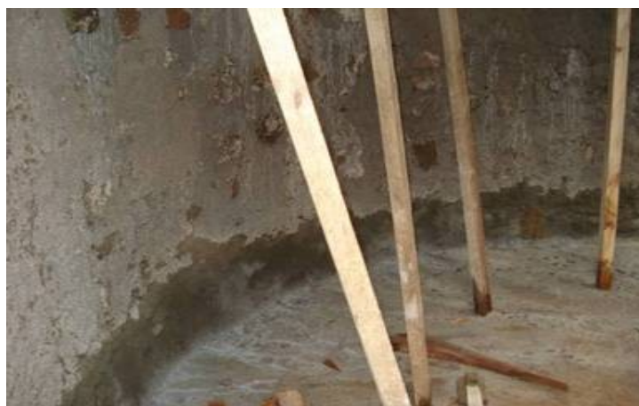
Biogassreaktor murt i naturstein. Forskalling av domen pågår
