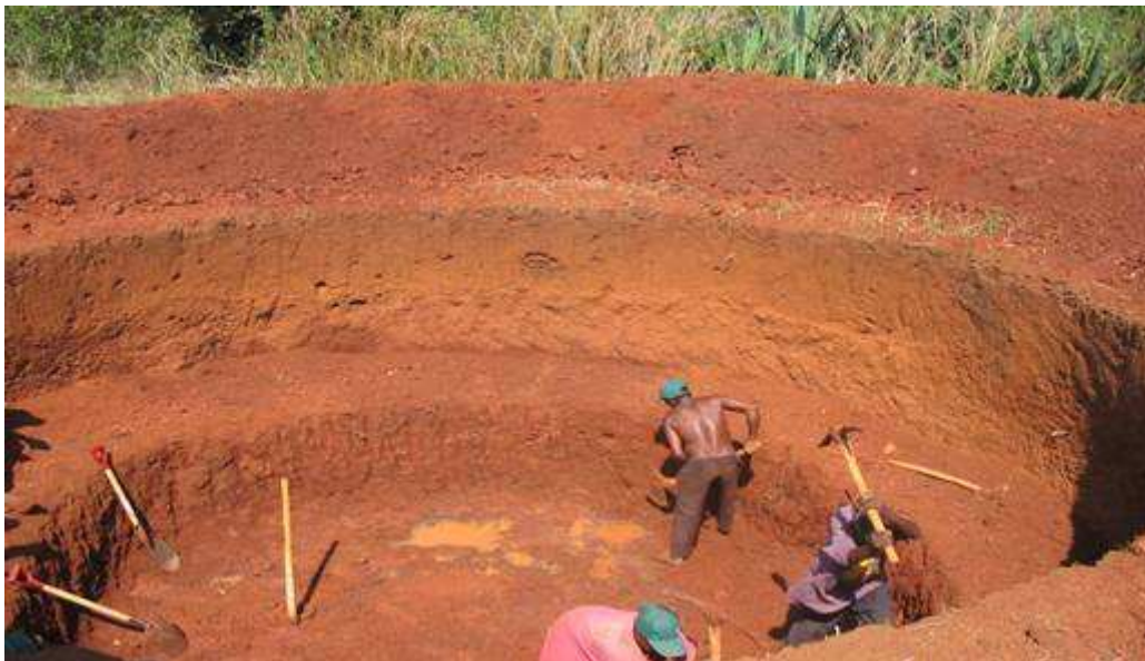
Gravingen nesten ferdig
